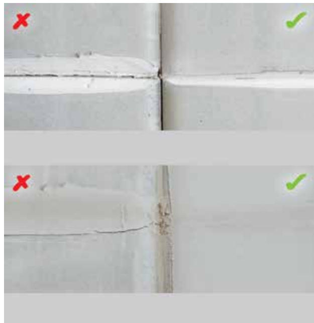
Helytelenül és helyesen megfózolt él, hézagolás után.
