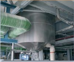
Korrodált részek mechanikai tisztítása, a belső felület kiszárítása tisztítás után
