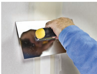
Vágott élnél is 30 cm szélesen szükséges a lesimítás.
