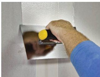
Az illesztést 30 cm szélességben simítsuk le.
