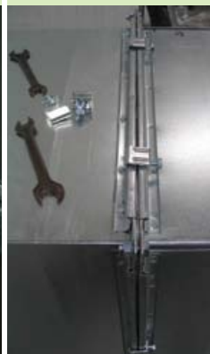
A peremek kerámiaszalag tömitésével és tűzálló ragasztással, acélpántokkal összefogatva
