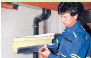
Orstech csőhéj szigetelés beszerelés előtt.
